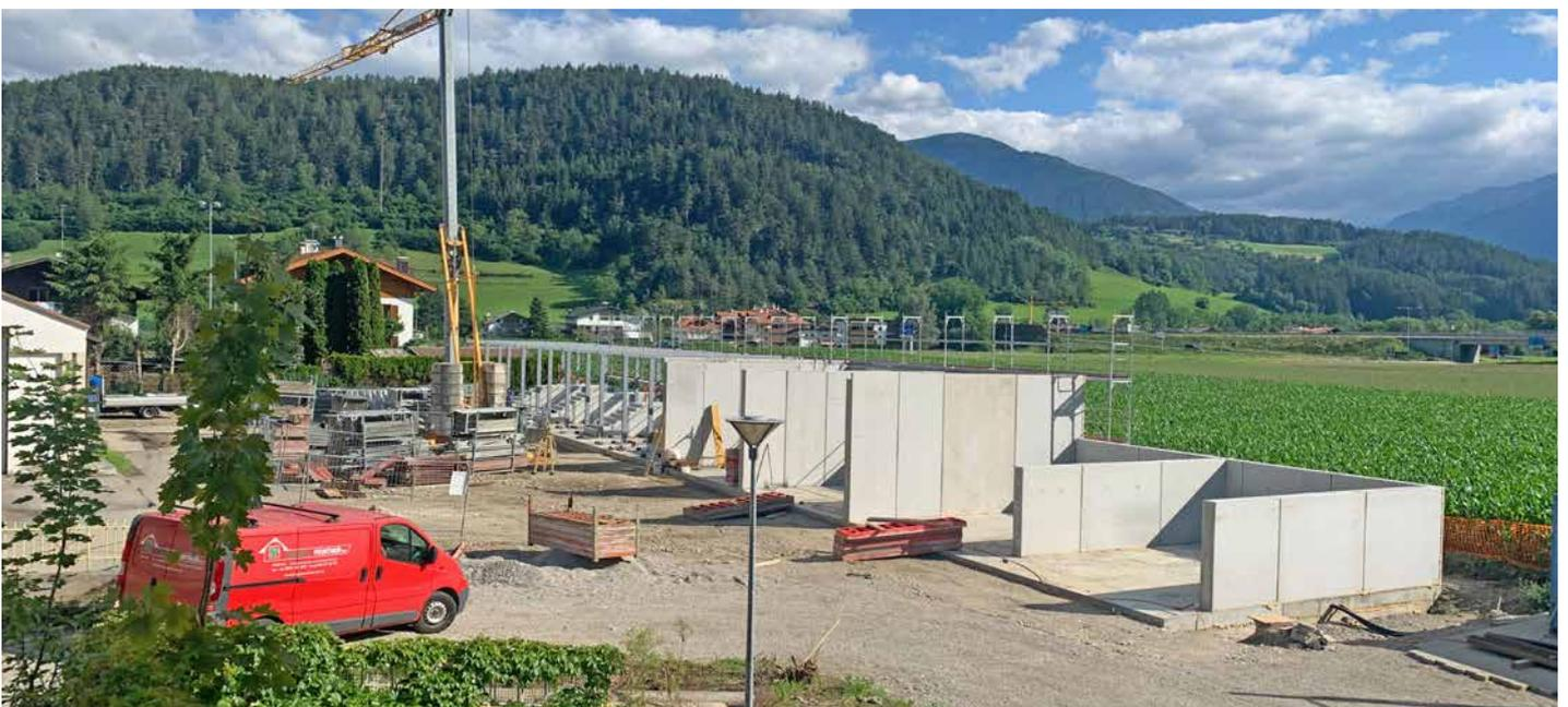
*In wenigen Tagen wurden die Mauern mit Hilfe von Fertigbauteilen hochgezogen.*
