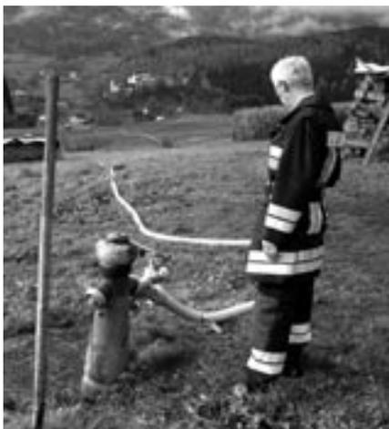
*Vom Hydrant in Fassing bis nach Sonnenburg haben die Wehrmänner am 28. Oktober in kürzester Zeit eine 600 Meter lange Leitung verlegt, um die Trinkwasserversorgung in Sonnenburg zu überbrücken.*
